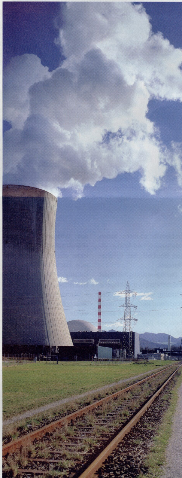
Atomkraftwerk: Die SBB sind nicht nur teils mit Atomstrom unterwegs, sie besitzen auch AKW-Anteile
